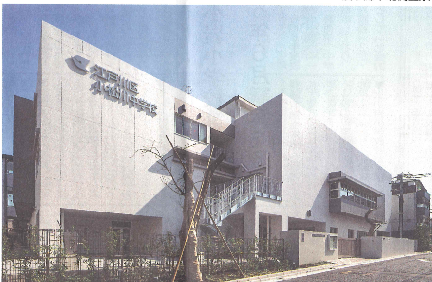
西校舎 北側外観
